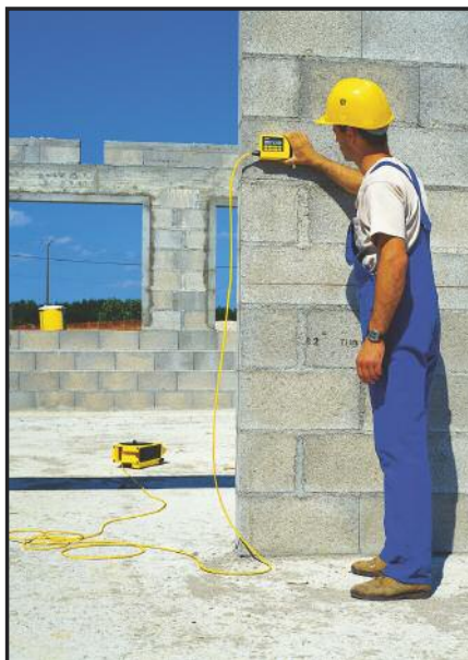
Pomiar różnicy poziomów za przeszkodą
