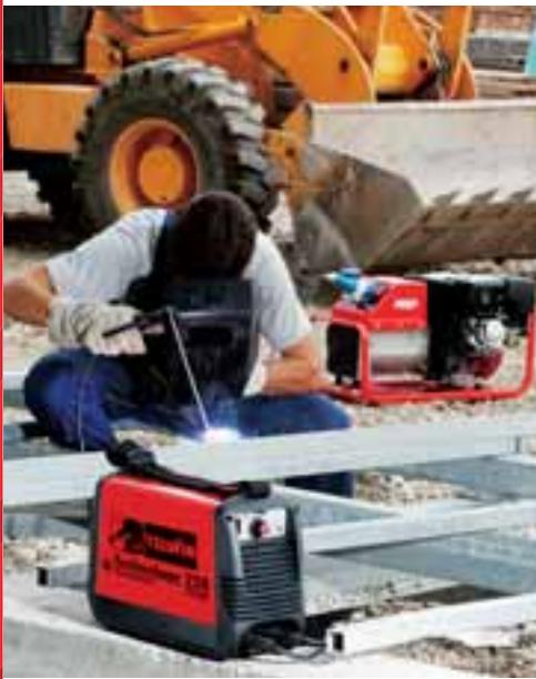
**PT** Todos os inversores TELWIN garantem um funcionamento correcto mesmo com variações da tensão de alimentação até 15%. Os motogeradores, se não forem estabilizados adequadamente, poderão não garantir. Os modelos específicos "MPGE, GE" garantem um melhor rendimento graças à proteção múltipla contra a instabilidade da corrente. A facilidade de transporte garante a máxima
